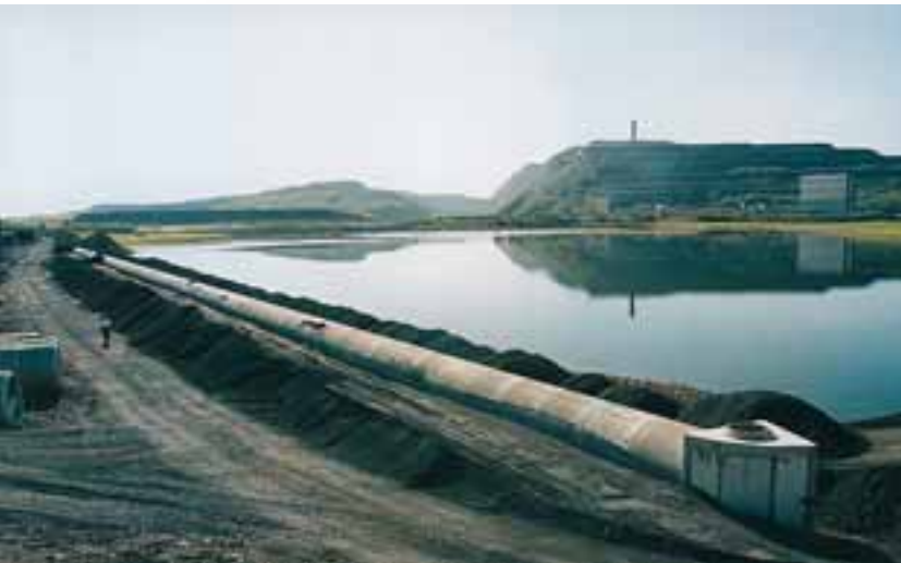
Ledning med 1,8 m invändig diameter vid Luossajärvdammen utanför LKAB i Kiruna.
